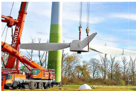
Im Oktober wurden die Windräder in Listerfehda abgebaut.
