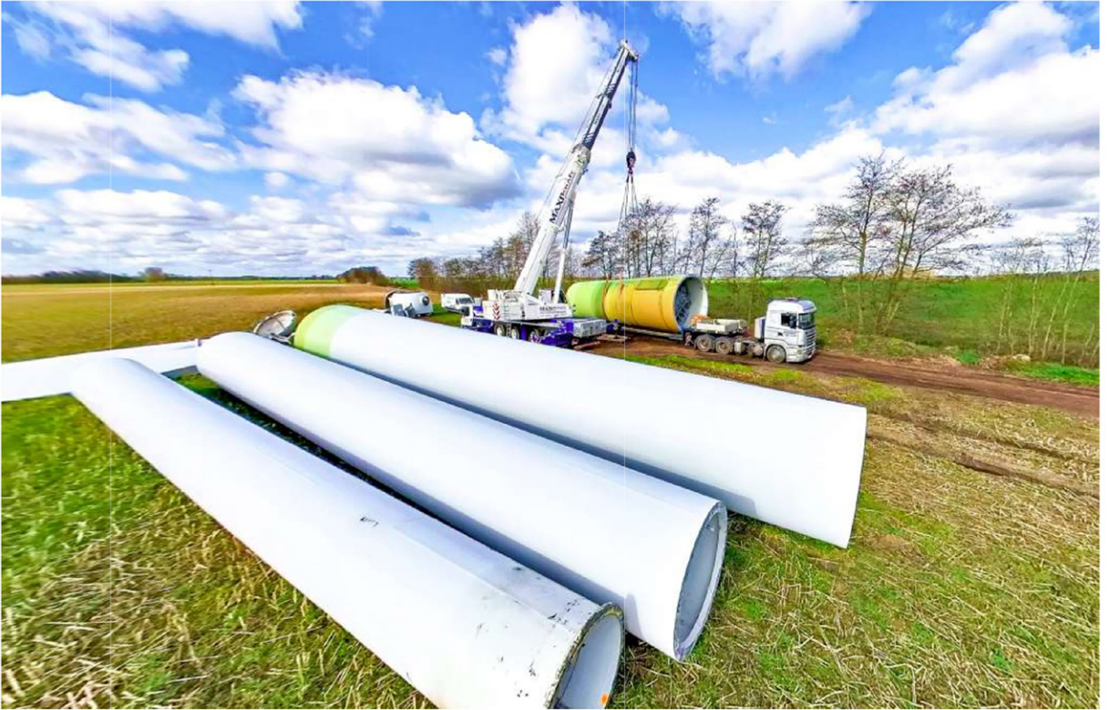
Fertig für die Reise in den Süden: Das Windrad vom Typ Enercon E-40 besteht aus vier Turmteilen, dem Generator und den Rotorblättern. In Italien wird es wieder aufgebaut.
